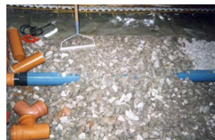
Beispielschnitt und Einbausituation für eine Flächdränage unter der Bodenplatte (nach Leißring)
