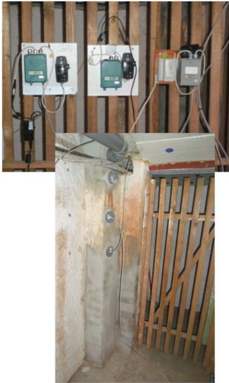
3 Kernbohrungen durch den Schornstein in den nicht unterkellerten Gebäudebereich und Differenzdruckmessungen im Schornstein sowie hinter der Wand
