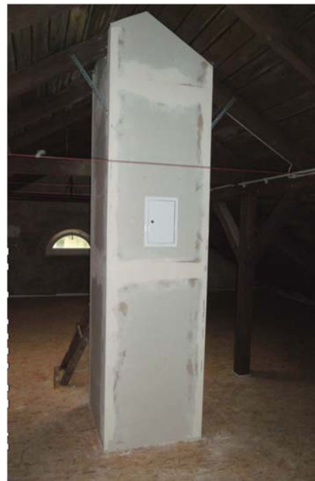
eingehauste Lüfteranlage mit Schalldämmung (Endzustand)
