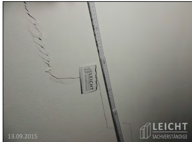
Abb. 1: typisches, setzungsbedingtes Rissbild
