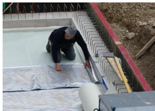
**Abb. 4:** Gasdichter Anschluss an Betonteile
