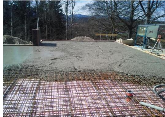
**Abb. 6:** Weiterer Aufbau mit Dämmung, und gegossener Bodenplatte
