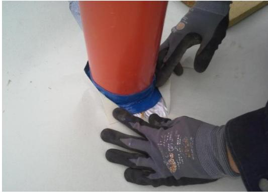
**Abb. 5:** Gasdichter Anschluss an eine Durchdringung / Rohr, Abdeckung der RadonProtect Folie mit Wikaflor Schutzvlies
