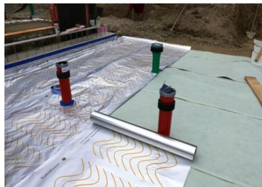
**Abb. 2:** Umodan® RadonProtect Folie auf Wikaflor Schutzvlies ausgelegt, mit einigen Durchdringungen
