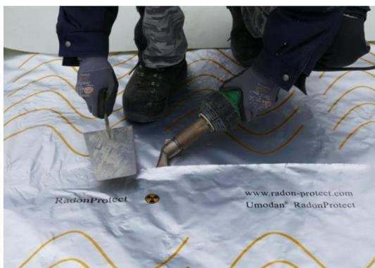
**Abb. 3:** Folienbahnen mit Heißluft radondicht verschweißen
