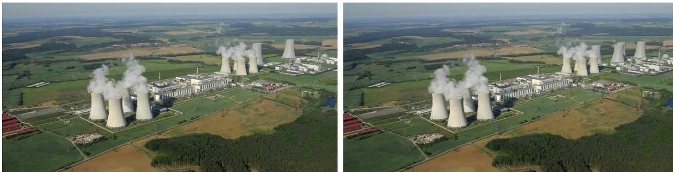
Abb. D.37: Gesamtkomposition der neuen Kernkraftanlage (ein Block mit der Leistung bis zu  $1 \times 1\,750\text{ MW}_e$ , ein und zwei Kühltürme pro Block) und EDU1-4
