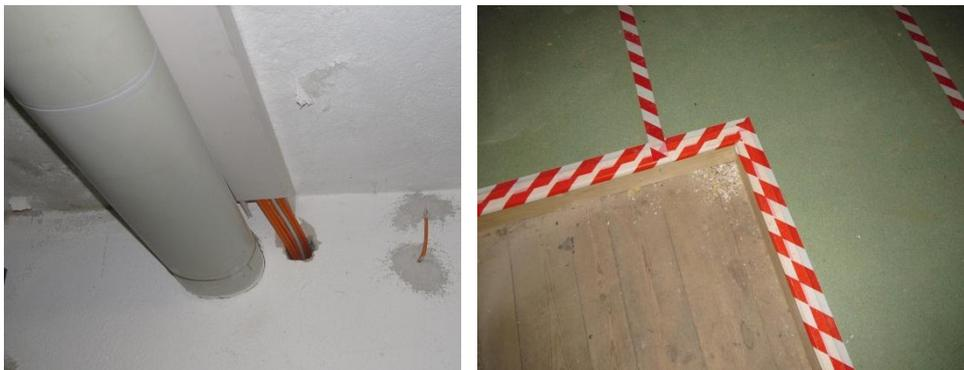
**Abb. 5 und 6:** Undichte EDV-Kabel-Durchführung und luftdichte Dachdämmung
