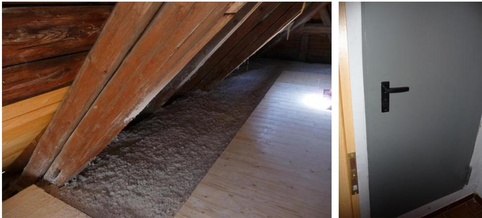
**Abb. 4 und 5:** Dachbodendämmung mit Cellulose und dichte Stahlkellertür
