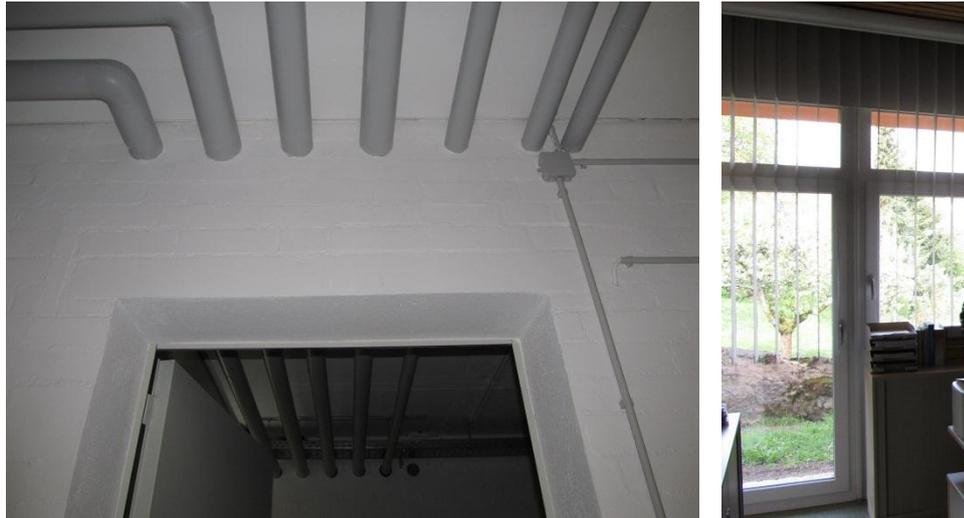
**Abb. 7 und 8:** Abgedichtete Rohrleitungen (im Hintergrund nicht abgedichtet) und neue Außenwand
