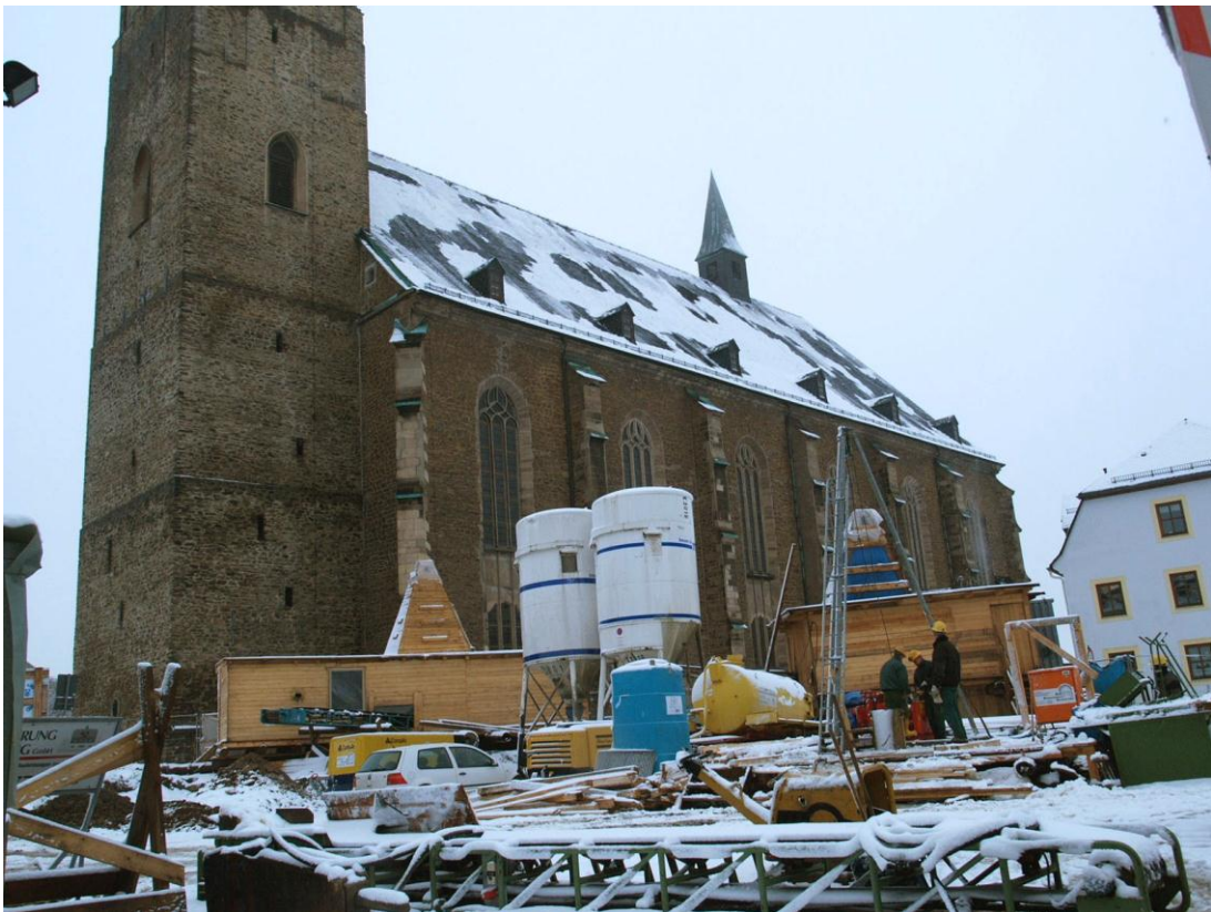
Abb. 6: Situation auf der Baustelle
