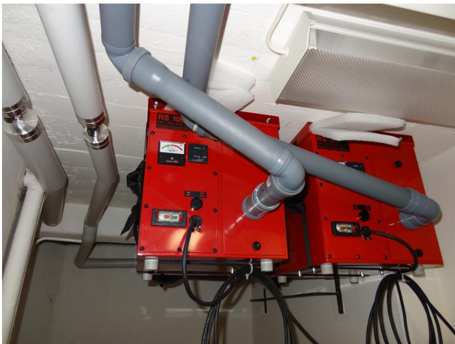
Abb. 1 Installationsbeispiel für einen RS 100-Radonsauger von Corroventa ®
